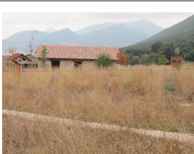
Foto 7: Cartore – Strutture giardino botanico mai portate a termine e in stato di abbandono e invase dalle erbacce
