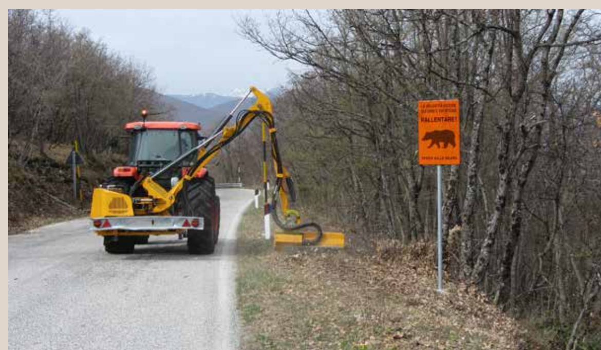
Manutenzione del bordo stradale sulla SR 83 “Marsicana”.
