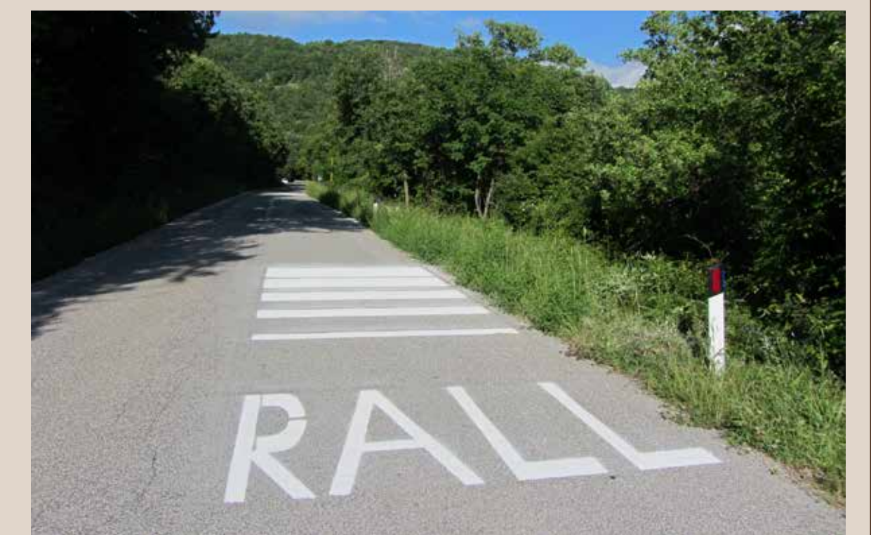
Sistema di rallentamento ad effetto ottico sulla SR 83 “Marsicana”.
