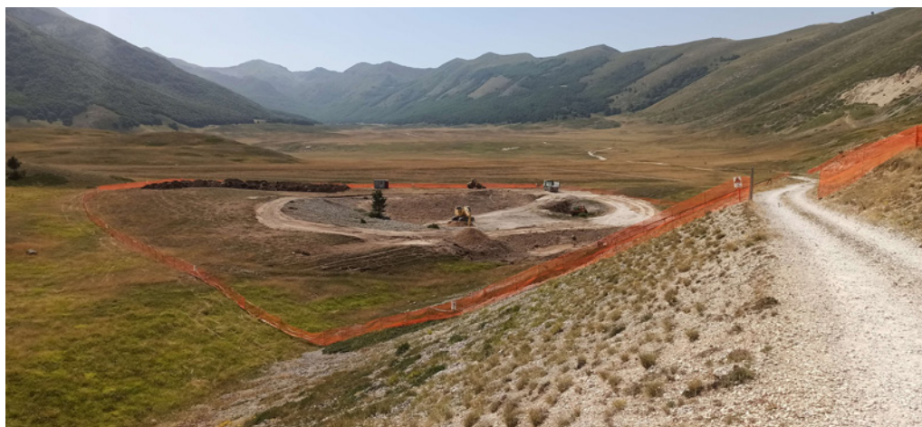
Lavori per lo stadio del fondo ai Piani di Pezza / Works for the Piani di Pezza cross-country ski Stadium (Ph. Fabrizio Cordischi).
